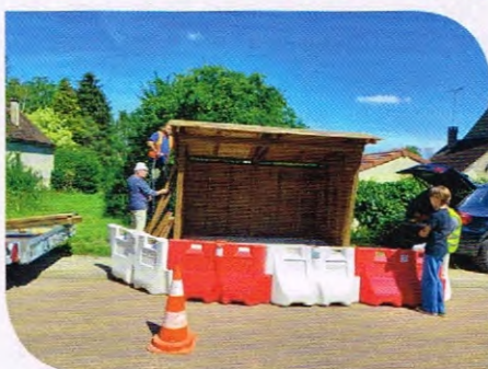
L'abri de bus construit totalement
