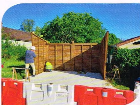
Le fond de l'abri de bus
