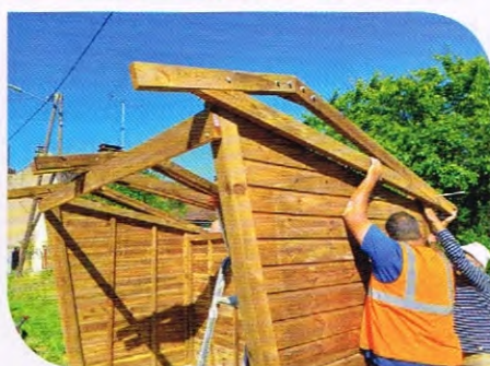
La base du toit de l'abri de bus
